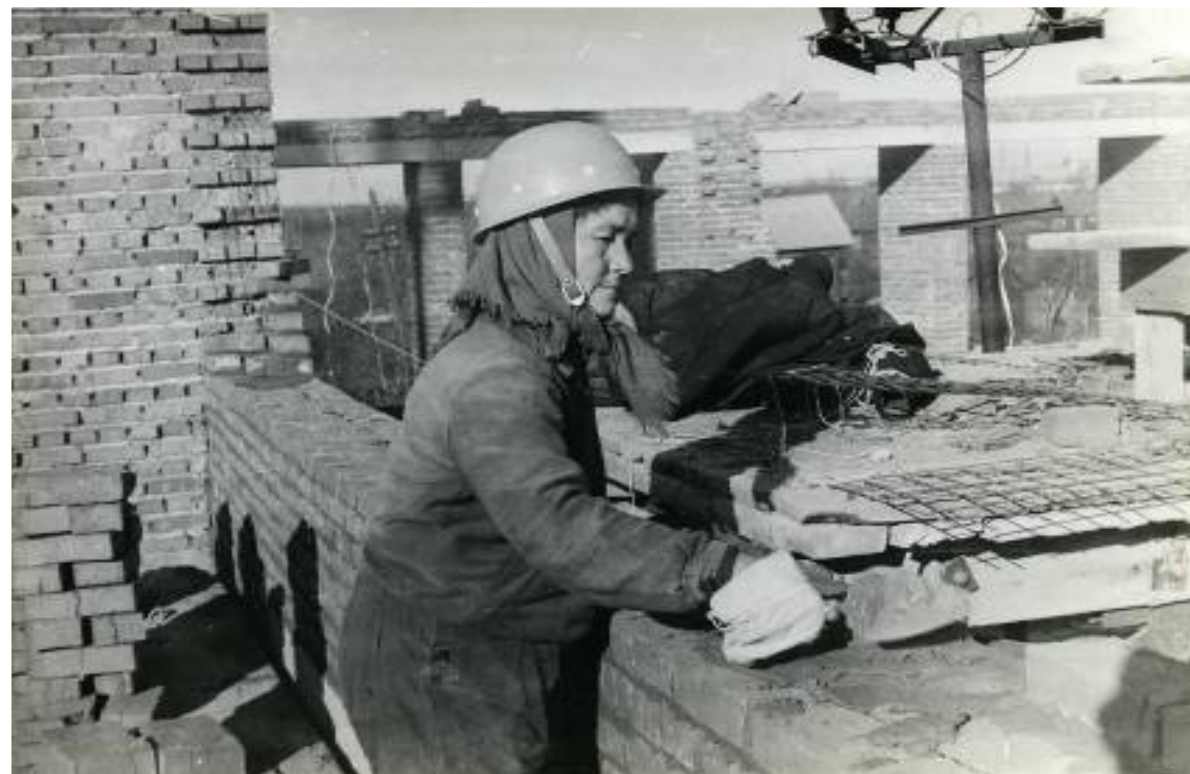
Абашева М.К., каменщица СУ-1 жилищно-строительного треста, на строительстве здания горсовета. Ижевск, 1975 г.
